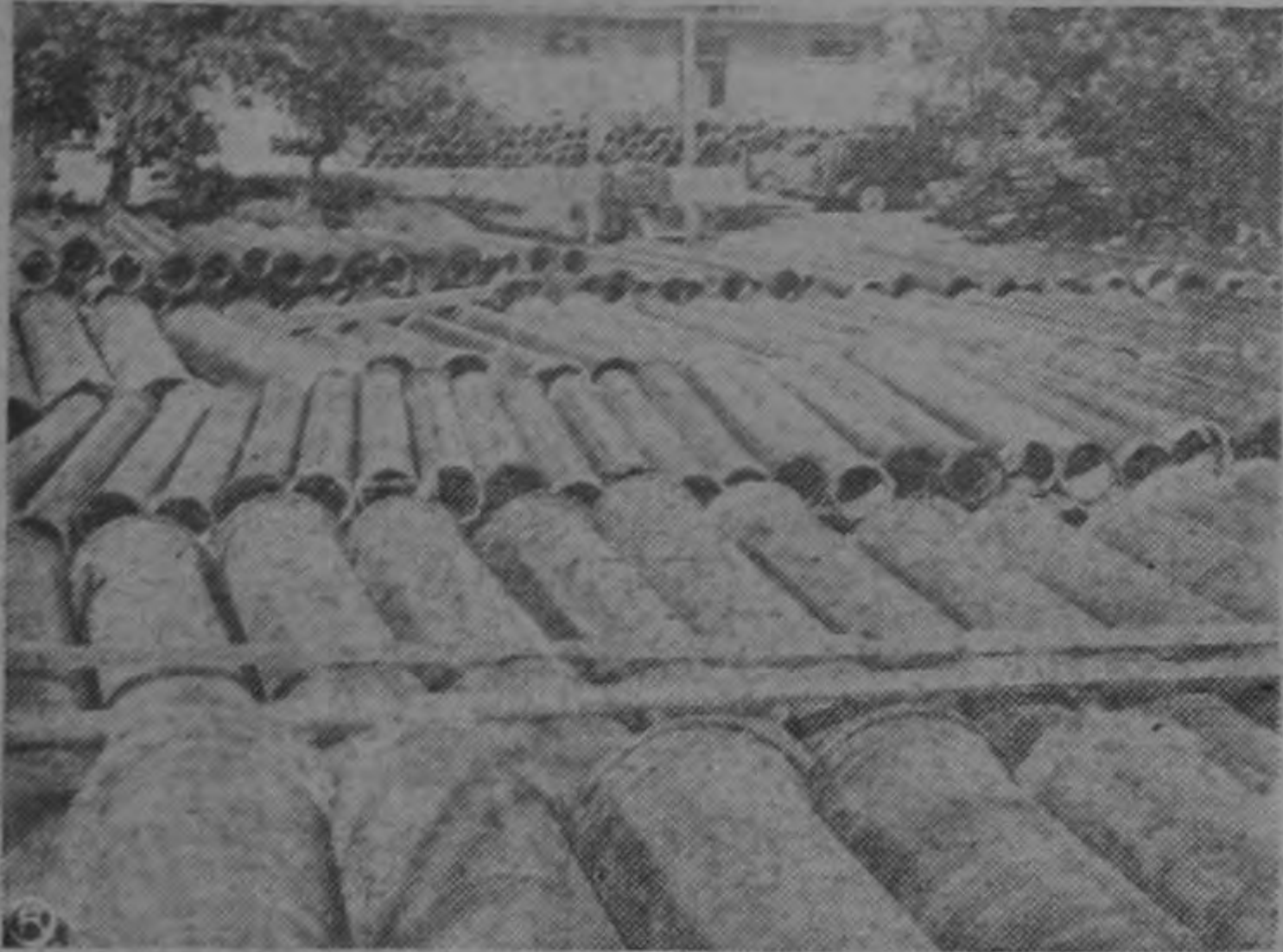
PARA LOS BARRIOS DEL SUR.—Esta impresionante cantidad de tubos, de treinta pulgadas de diámetro, corresponde a un primer embarque que acaba de llegar al puerto de Puntarenas, de la adquisición hecha por la Municipalidad de San José para la obra de la cañería de los Barrios del Sur.
