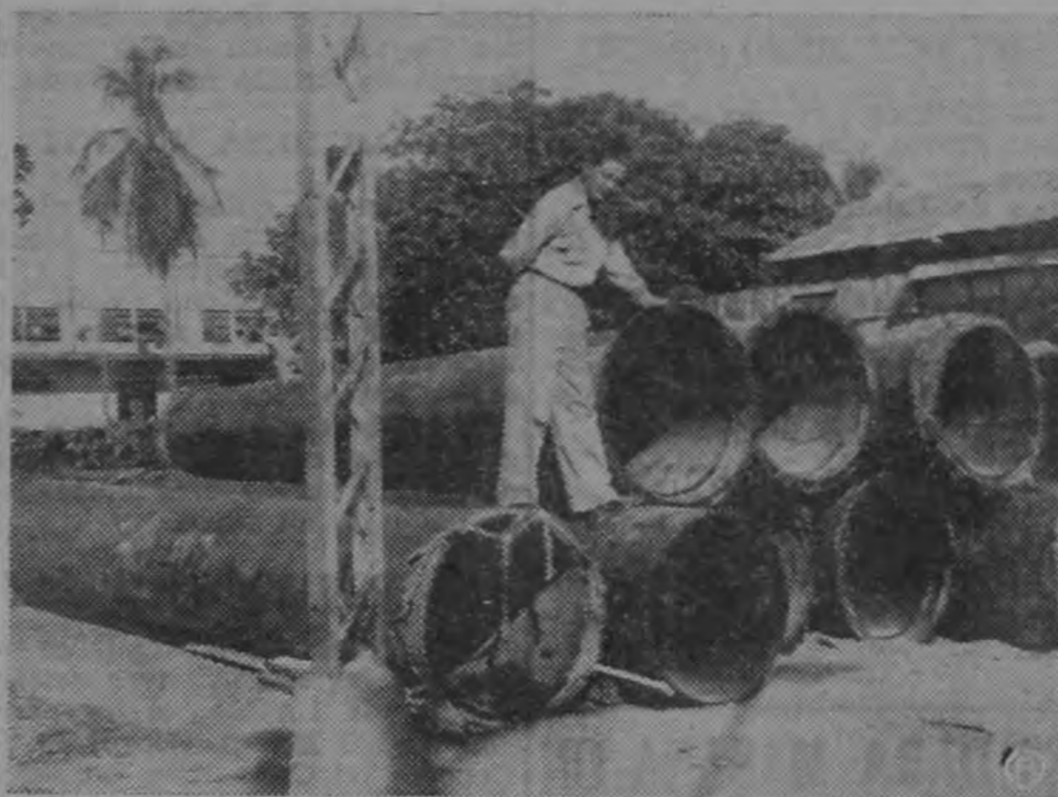
El Ingeniero Civil don Fernando Rojas, Jefe de la Sección de Cañerías y Cloacas de la Municipalidad de San José, recibiendo la tubería en Puntarenas, nótese la amplitud del diámetro de los tubos.
